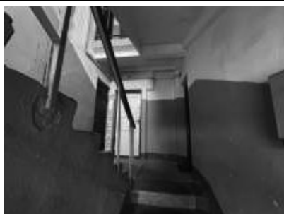
1.stāva kāpņu telpa
